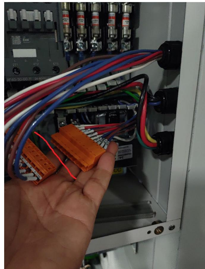
Câbles de chauffage du compresseur et de ventilateur :
