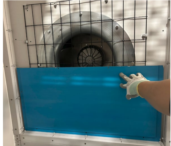
FIGURE 3: EXEMPLE D'INSTALLATION DU PANNEAU SUR L'OUVERTURE DU VENTILATEUR
